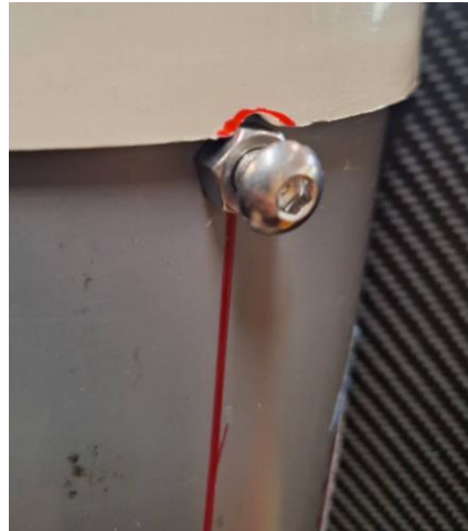
底座使用3支膨脹螺絲固定端點
